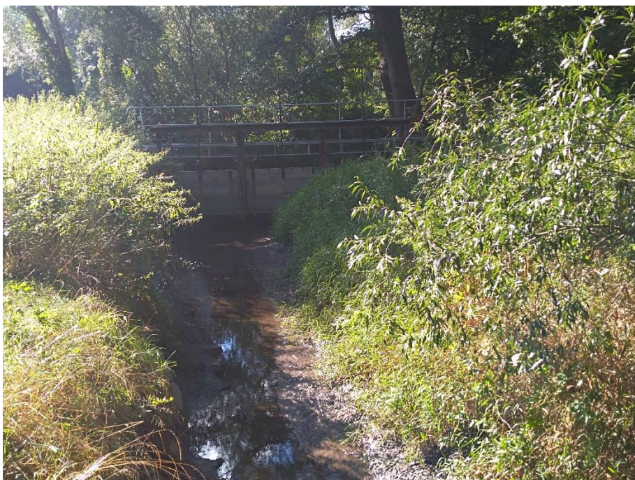
Foto č. 4 – Pohled na stavidlový objekt (Nápusťný objekt II) a prakticky suché koryto v době průzkumu
