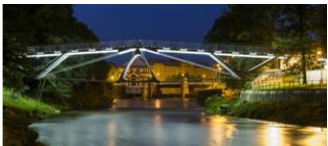
Мостик через р.Орлице
