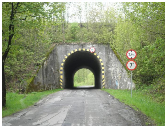
ZDJĘCIE NR 2: SKRZYŻOWANIE DROGI I LINII KOLEJOWEJ (GŁUSZYCA-GRZMIĄCA)
