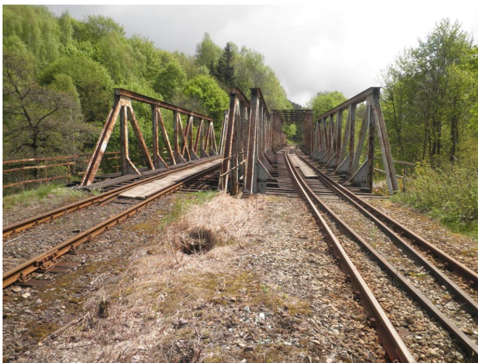
ZDJĘCIE NR 6: MOST NA LINII KOLEJOWEJ NR 286 - PRZYJAZD DO GŁUSZYCY
