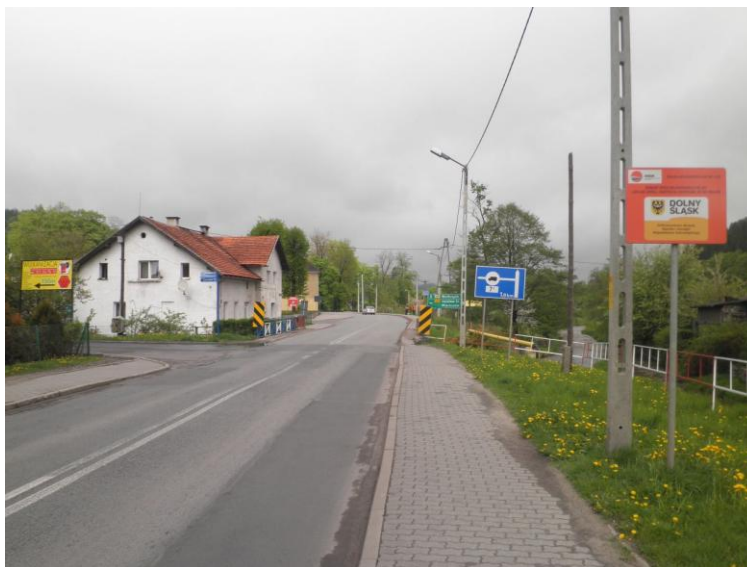
ZDJĘCIE NR 3: DROGA NR 381 GŁUSZYCA-UNISŁAW ŚLĄSKI (przy skrzyżowaniu z drogą 380)
