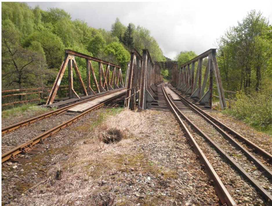
FOTO Č. 6: MOST NA ŽELEZNIČNÍ TRATI č. 286 - PŘÍJEZD DO GLUSZYCE
