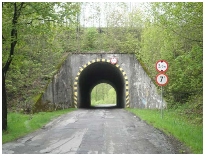
FOTO Č. 2: KŘÍŽENÍ SILNICE A ŽELEZNICE (Głuszyca-Grzmiąca)
