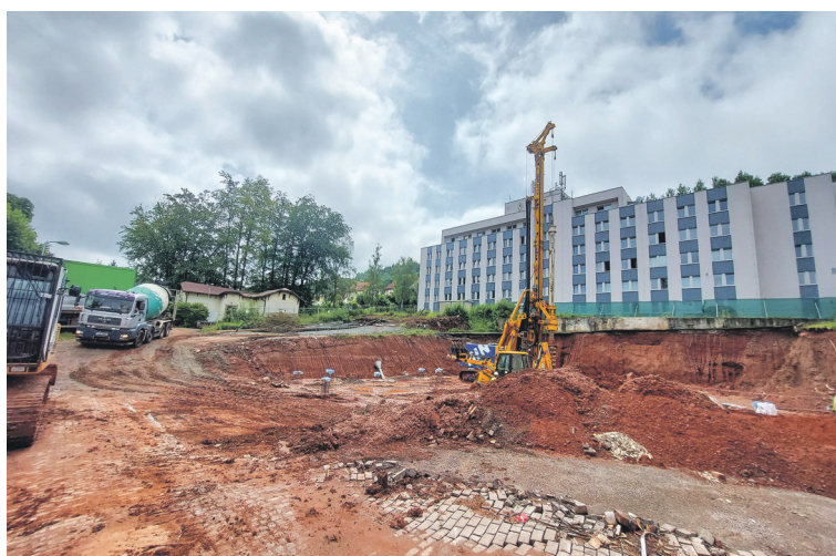
Začátek dalších stavebních prací v trutnovské nemocnici.
