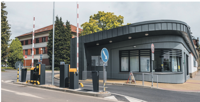
Změna vstupu s lékárnou do areálu nemocnice Jičín II.
